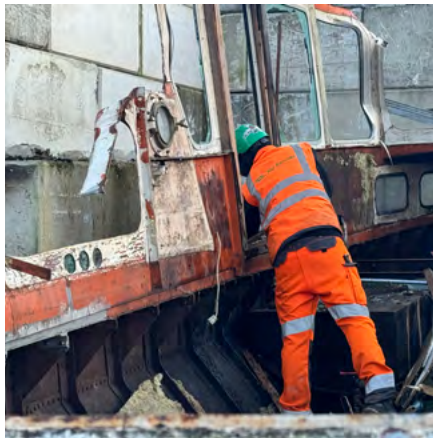
Démantèlement en cours.
